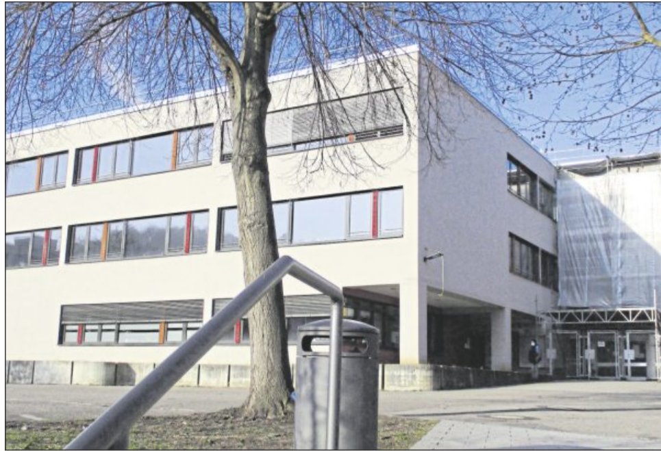
Das Schulzentrum Süd wird für insgesamt 13,45 Millionen Euro saniert.
