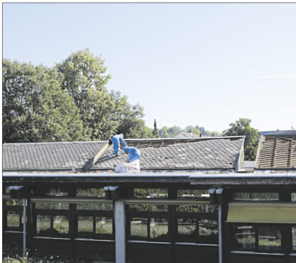
Abrissarbeiten am Grundschulgebäude der Rainbrunnenschule.
