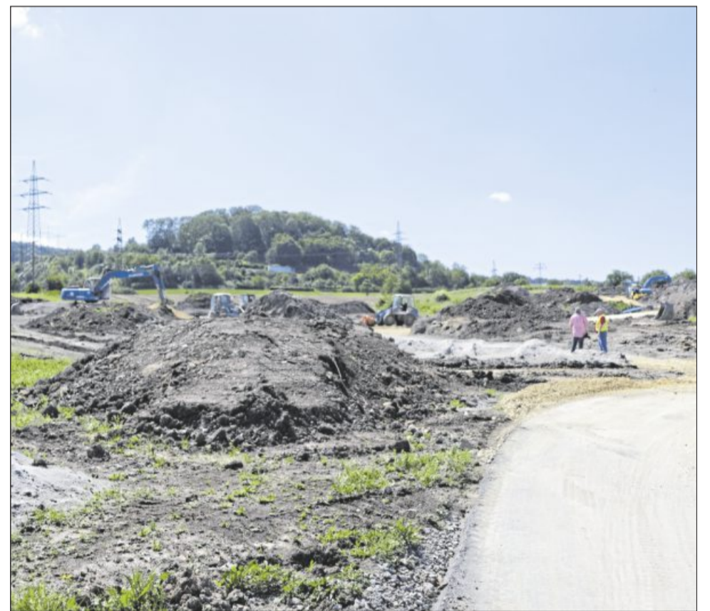
Die Zufahrtsstraße zum neuen Baugebiet „Obere Straßenäcker“ ist bereits fertig.
