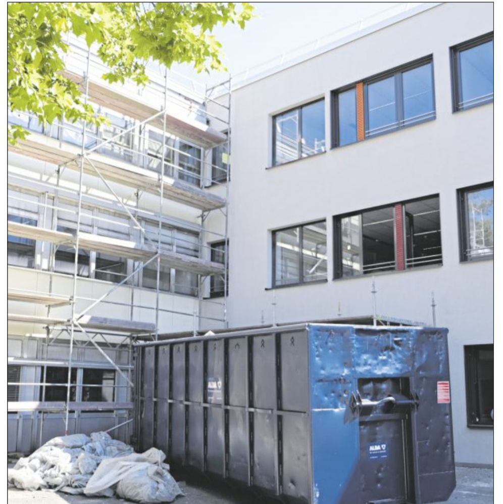
Fassadensanierung an der Gottlieb-Daimler-Realschule.
