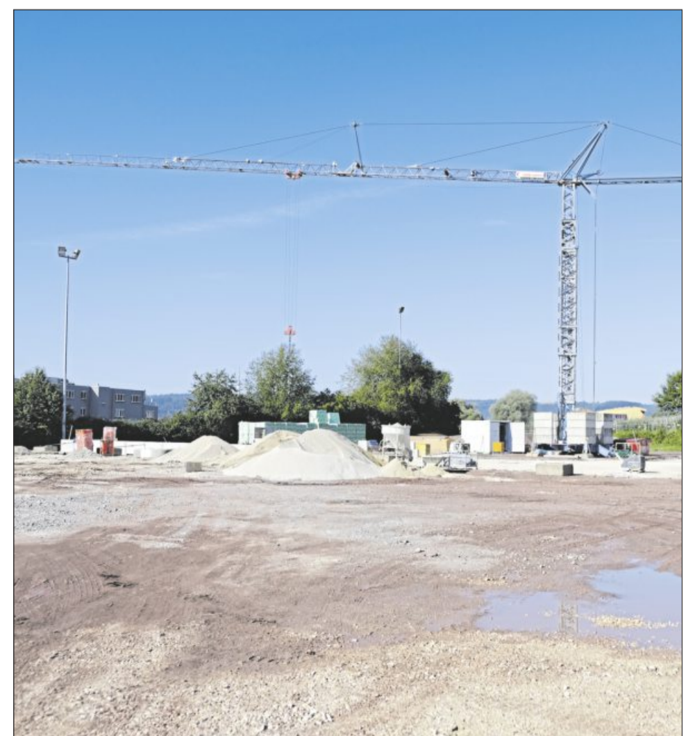
Hier entsteht in den kommenden Monaten die Kita Stöhrerweg.
